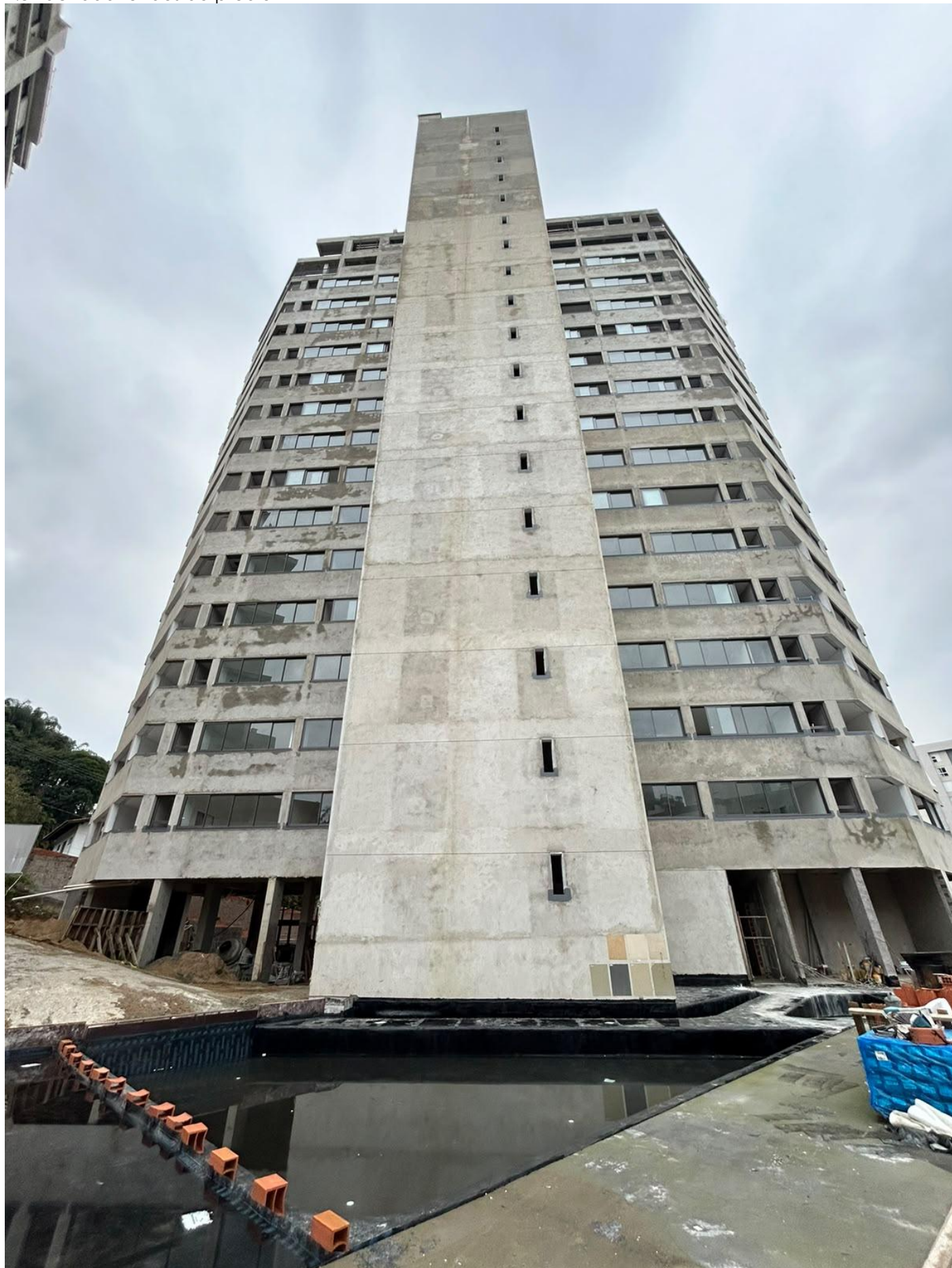
2.8 Fachada fundos do prédio
