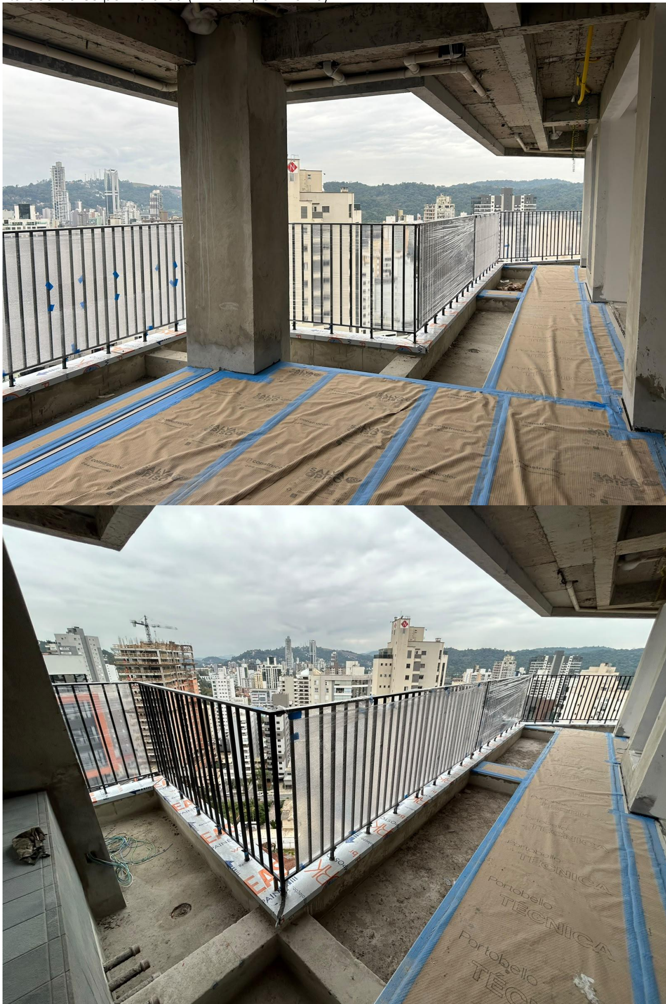
2.3 Guarda-corpo metálico (14º e 15º pavimento)
