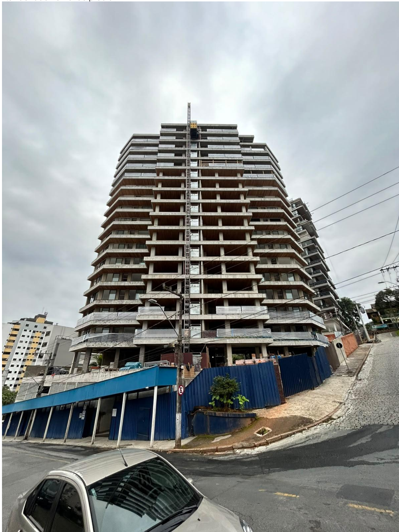
2.8 Fachada frontal do prédio
