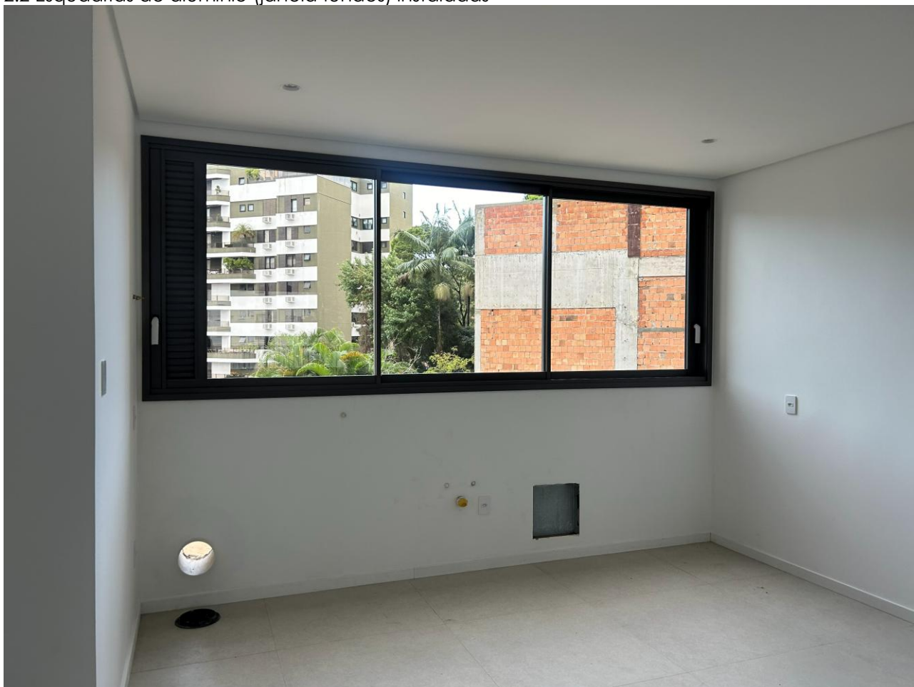
2.2 Esquadrias de alumínio (janela fundos) instaladas
