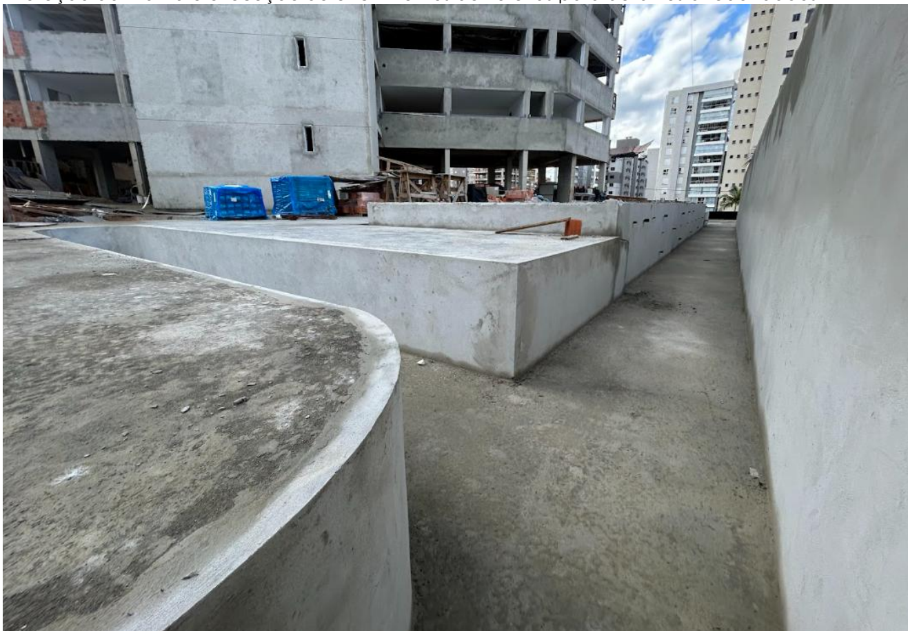
2.8 Proteção da manta e execução de enchimentos de floreiras para detalhes arredondados
