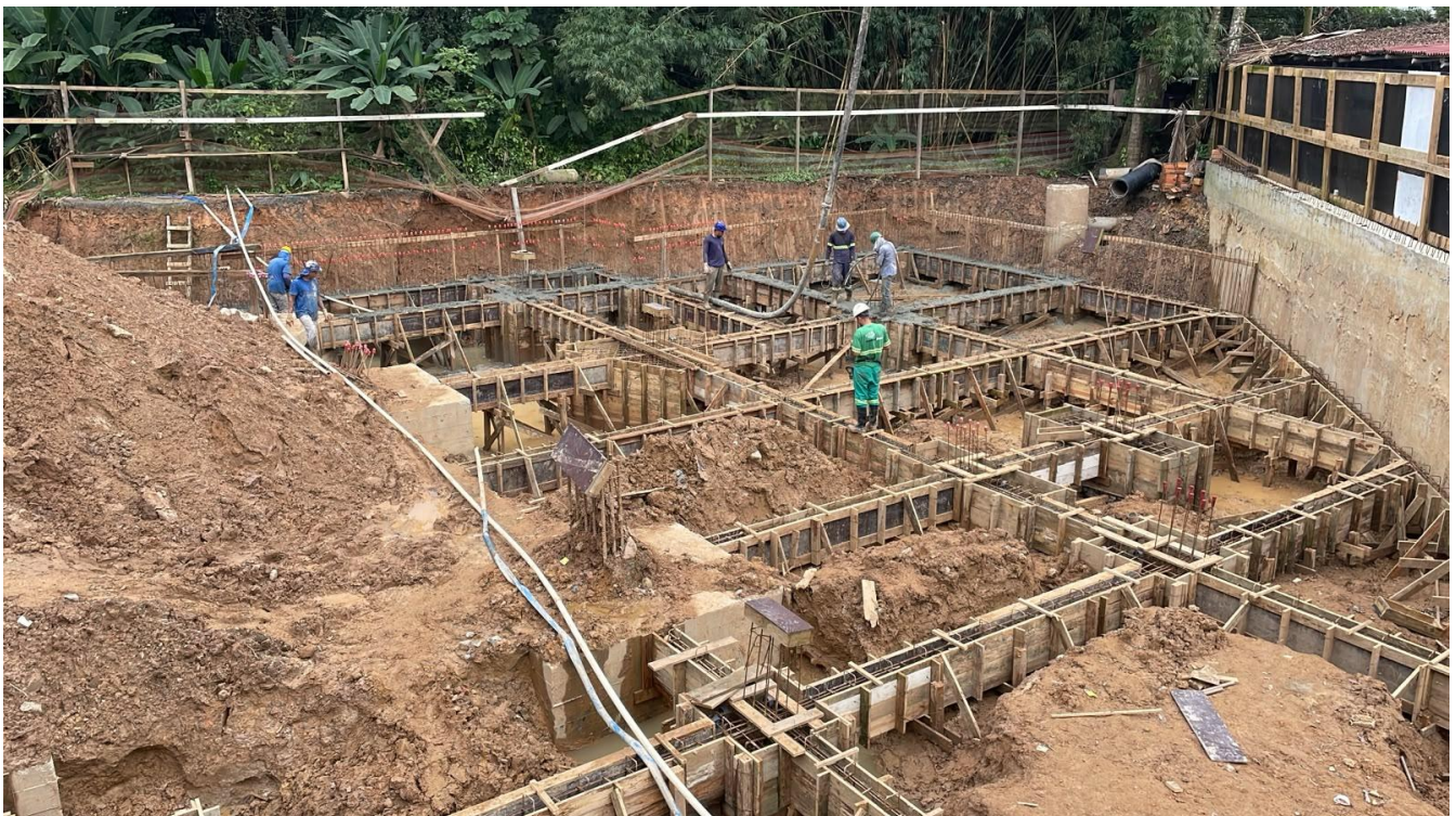
2.6 Concretagem último trecho – Finalização fundação
