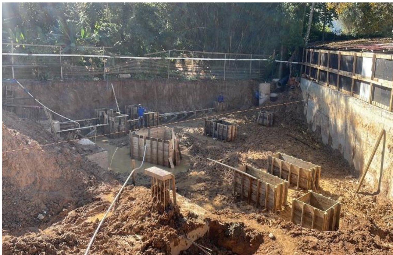
2.5 Execução formas último trecho da fundação
