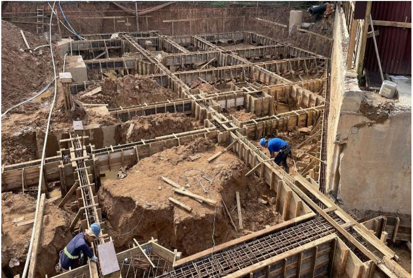
2.6 Concretagem último trecho – Finalização fundação
