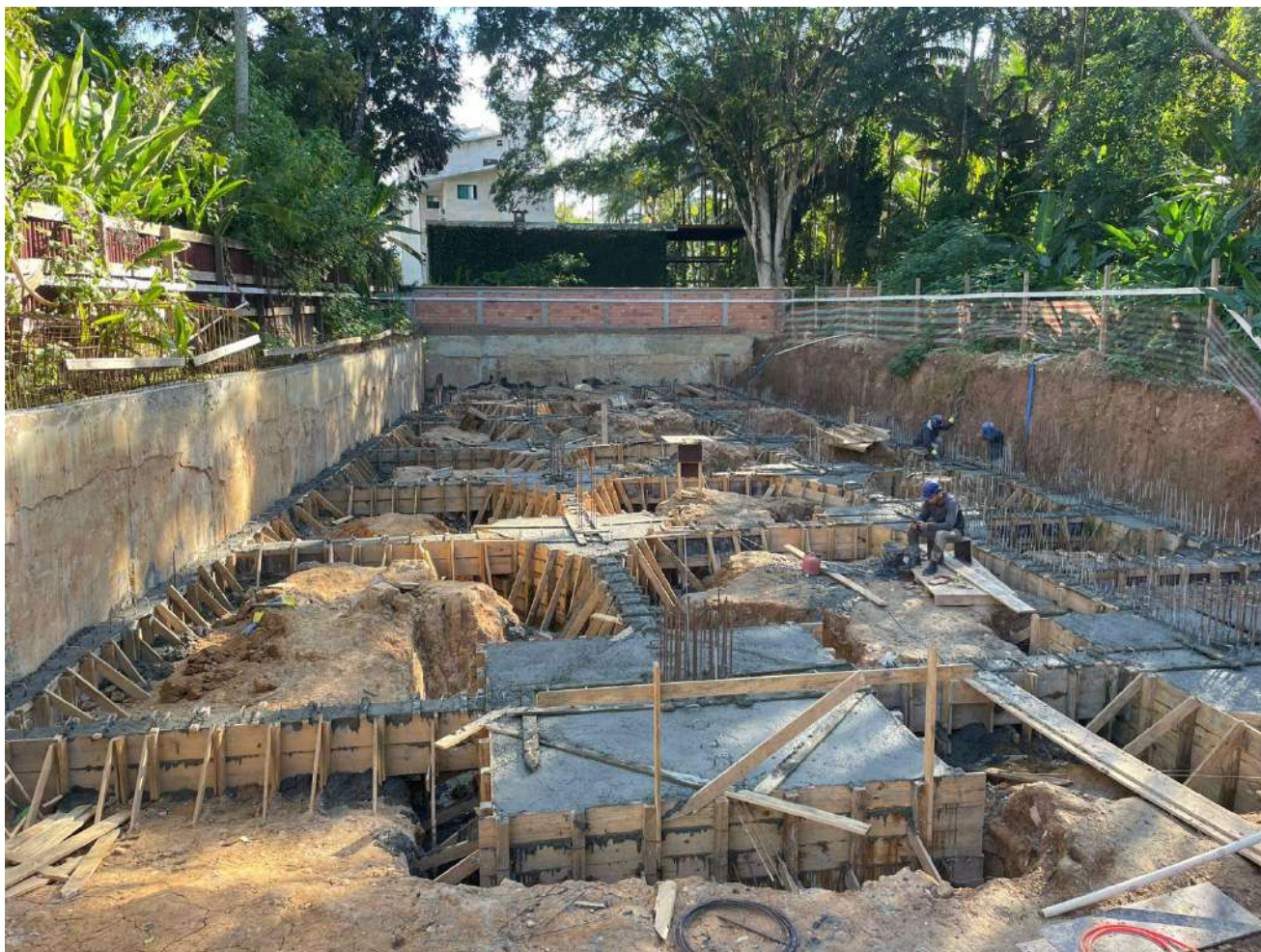
2.2 Reaterro e desforma do trecho concretado
