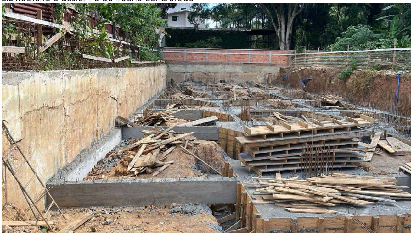
2.2 Reaterro e desforma do trecho concretado
