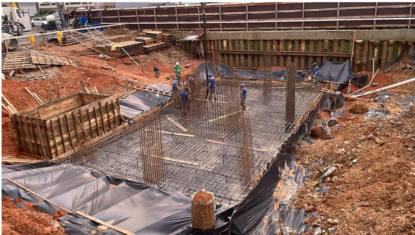
2.2 Execução das vigas e blocos acima e ao redor do bloco elevador social
