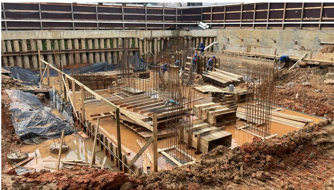
2.2 Execução das vigas e blocos acima e ao redor do bloco elevador social
