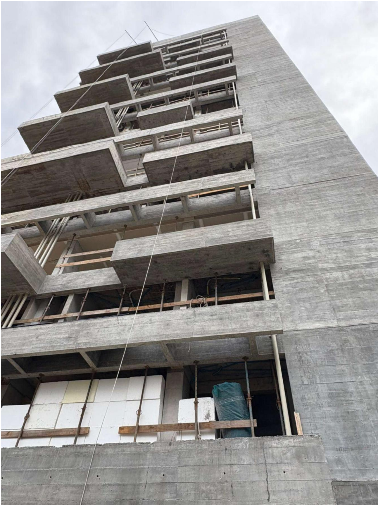
2.2 Fachada Lateral - Estucagem concreto aparente.
