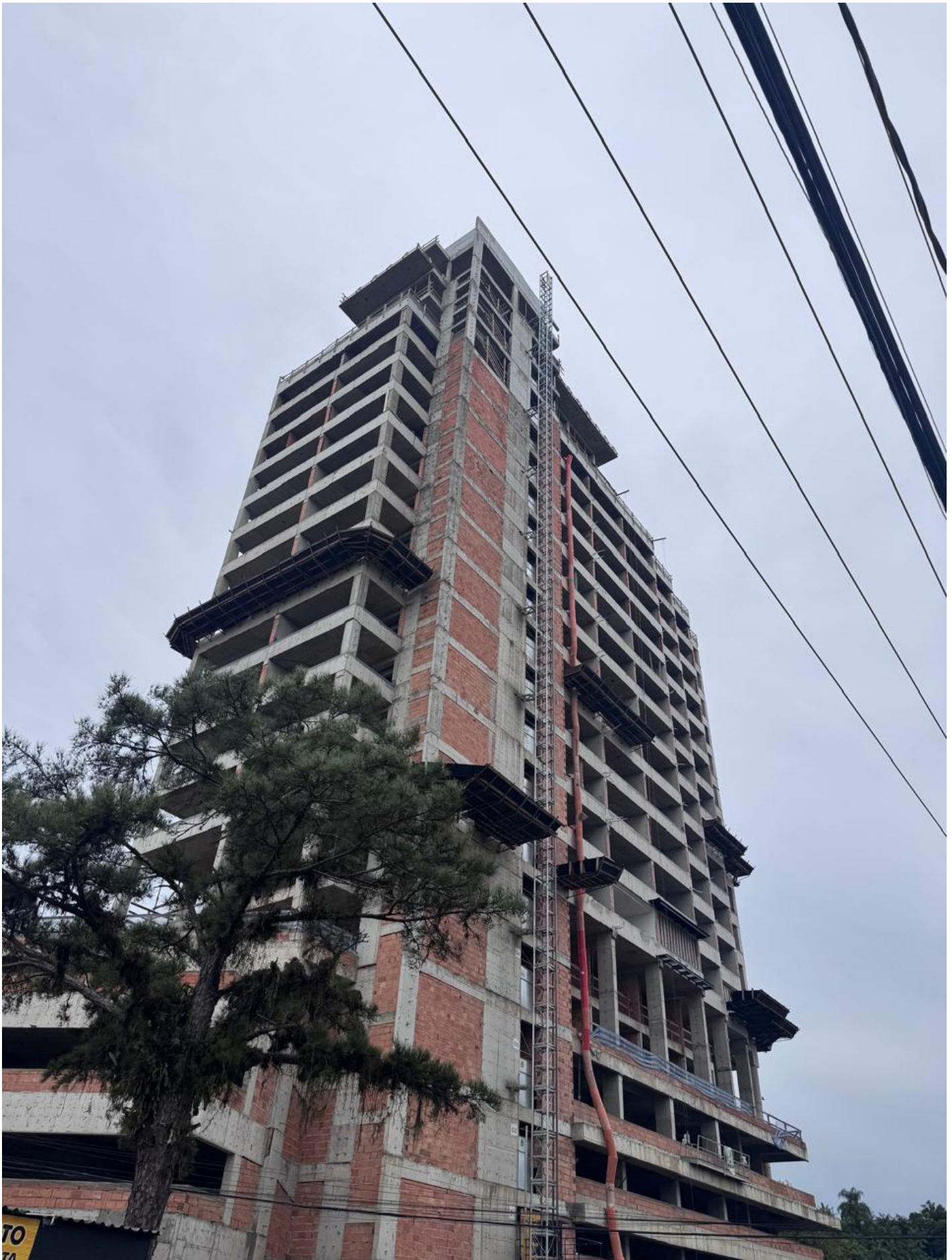
2.8 -Vista diagonal fundos.
